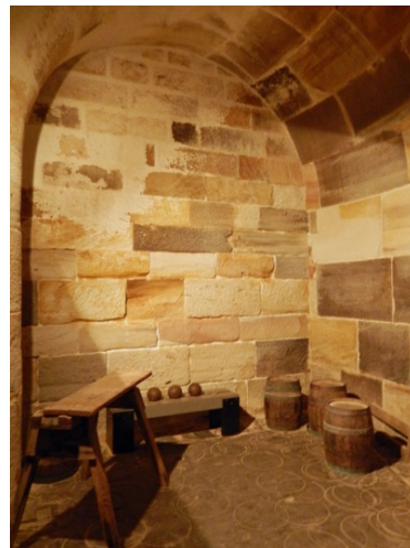
(d) Room TB4 looking east
