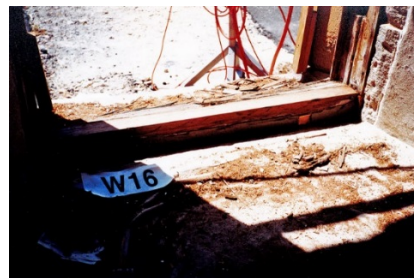
(d) Window sill patched
