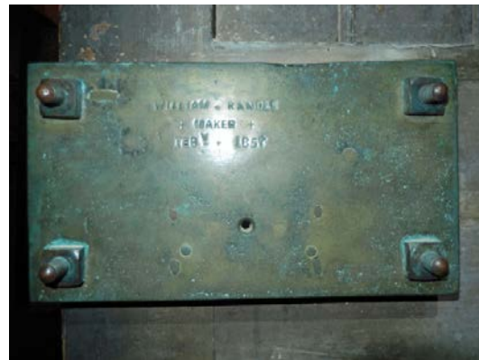
(d) Detail of original lock to door on Room TB4
