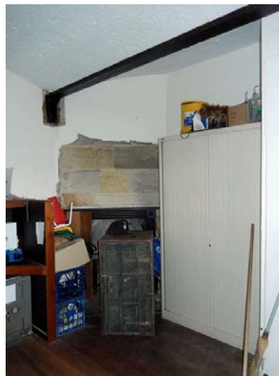
(d) Room B12 looking south to fireplace
